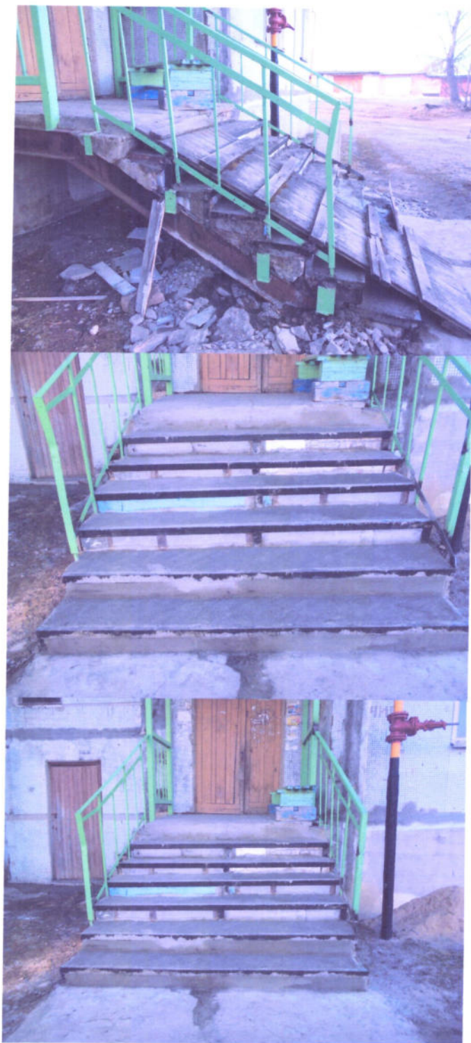
фото 409-4 ступеней после ремонта
