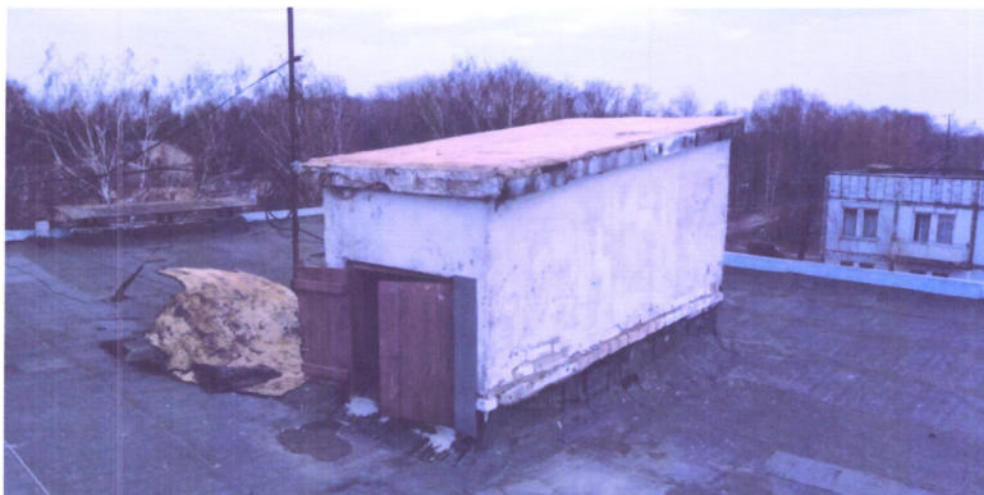
Фото 405 АВР выход на кровлю 09.04.20г
